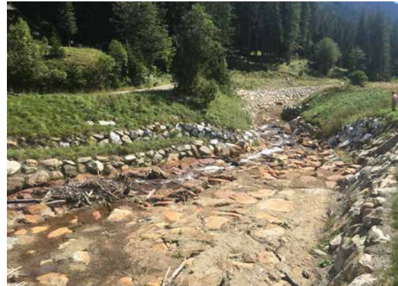
Abb.1: erhebliche Unterschreitung der vorgeschriebenen Restwasserdotations*
