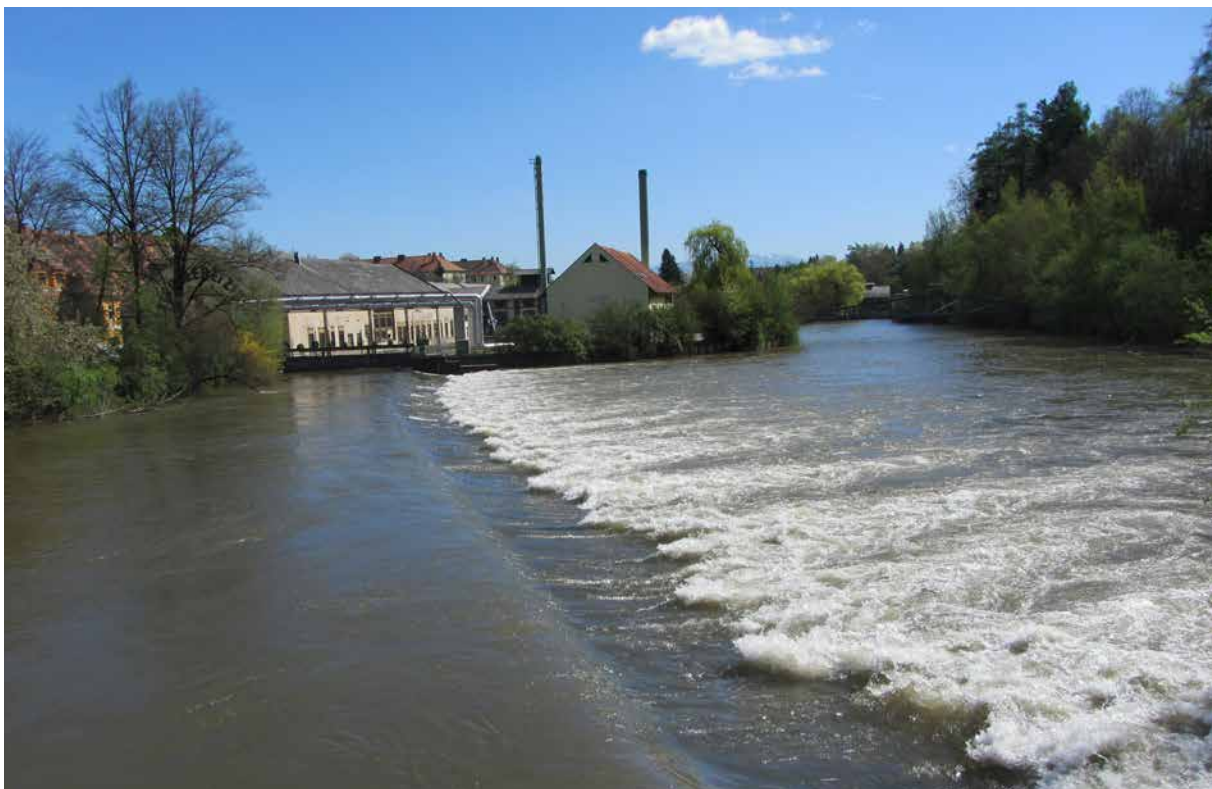
Eines der drei Kraftwerke in Judenburg
