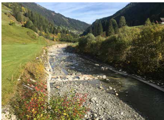
Abb.4: viel zu geringe, aber Bescheid konforme Restwassermenge*
