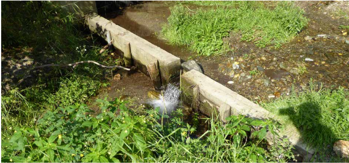
Unzureichende Restwasserabgabe und Verlandung im Staubereich
